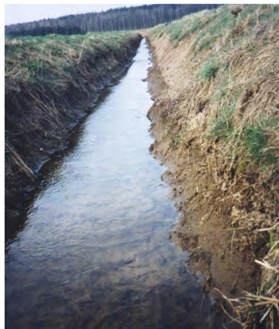
Figur 16. Raka jordbruksdiken fungerar bra som vattenledare men mycket dåligt som naturligt reningsverk.
